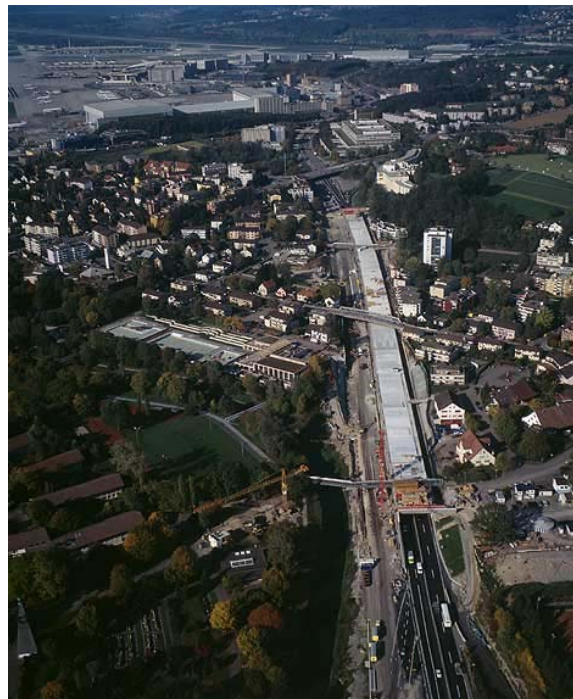
Abbildung 11: Autobahn Opfikon während der Bauphase im Oktober 2003. Quelle: Kanton Zürich (2006a)
